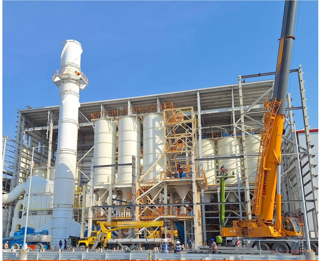
Savelli Technologies S.r.l. - Impianti di Preparazione e Recupero Terra per nuova fonderia in Messico
