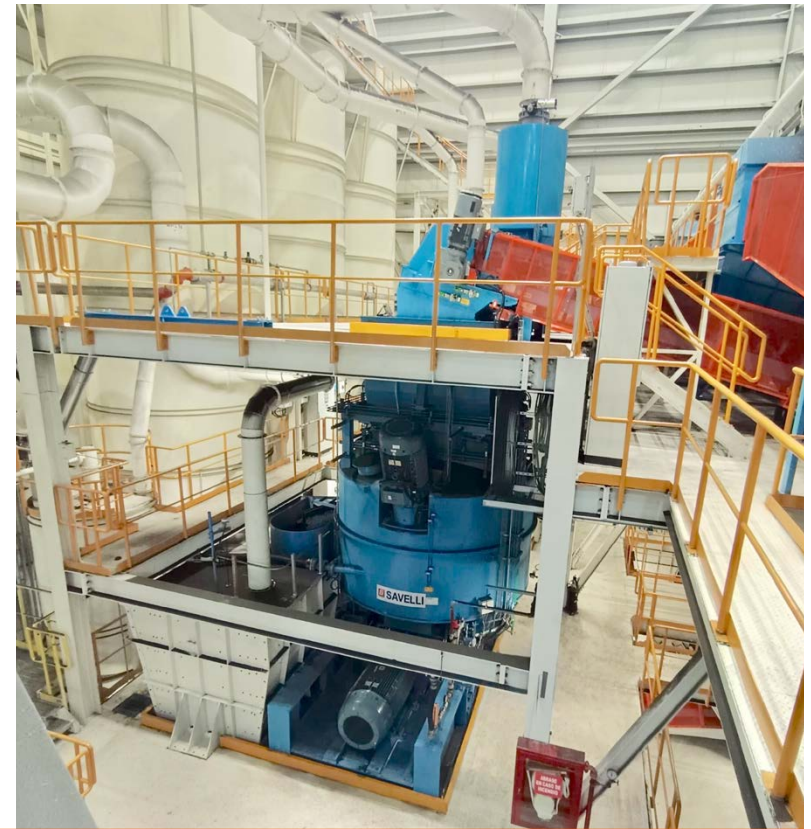
Impianto di Preparazione Terra per la nuova fonderia di Brembo, Messico
