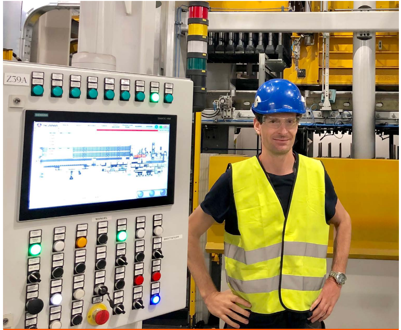
Sistema SCADA di Supervisione presso la fonderia SCANIA, Svezia
